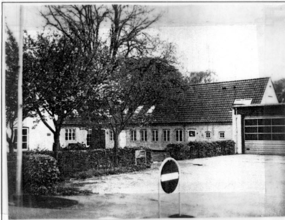
Gårdrummet ved Staldgården set fra Bagerstræde med den tidligere Falckstation til højre. Der ses flere eksempler på vinduer og døre i facaderne. Desuden ses flere af de store og skæmmende tagvinduer.
